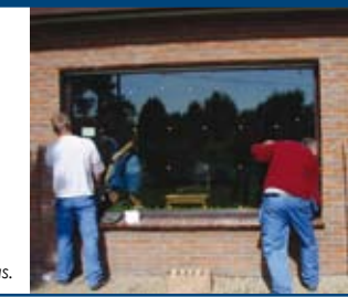
Vervanging van enkel glas door hoogrendementsglas.
