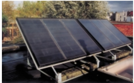
Zonnecollector: productie van warm water
