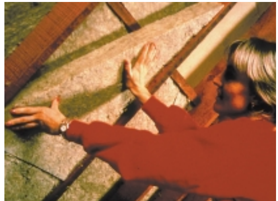
Isolatie tussen de kepers
