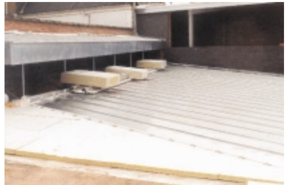
Dakisolatie bij plat dak
