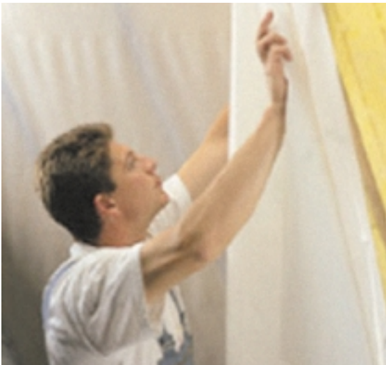
Een luchtscherm is absoluut noodzakelijk bij luchtopen materialen
