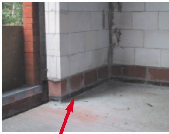
Gebruik van cellenglas om koudebrug te vermijden
