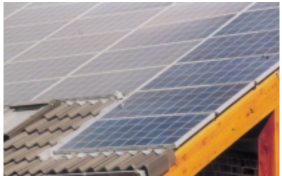
Fotovoltaïsche zonnepanelen: productie van electriciteit
